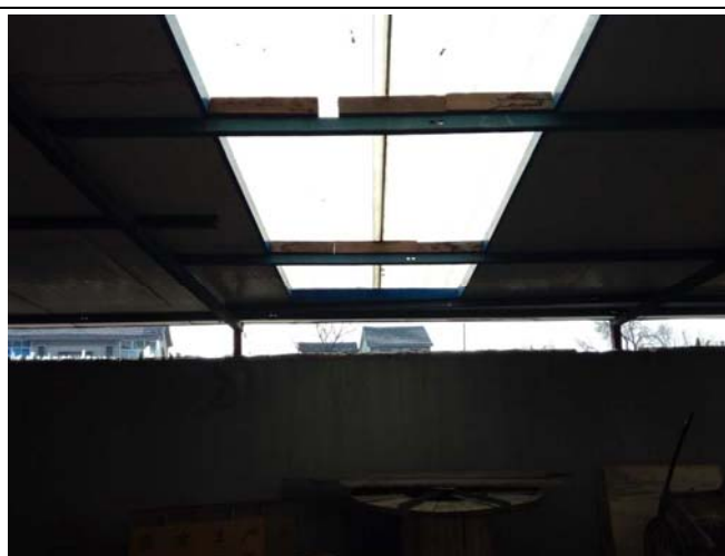
项目南侧现状
